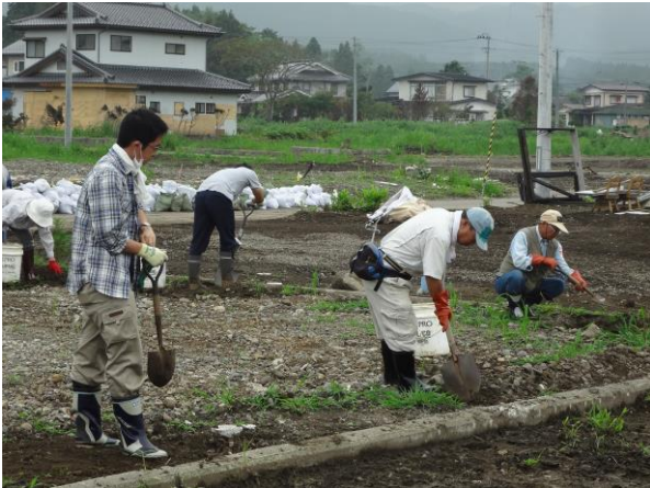
個人宅のガレキ片付け作業
